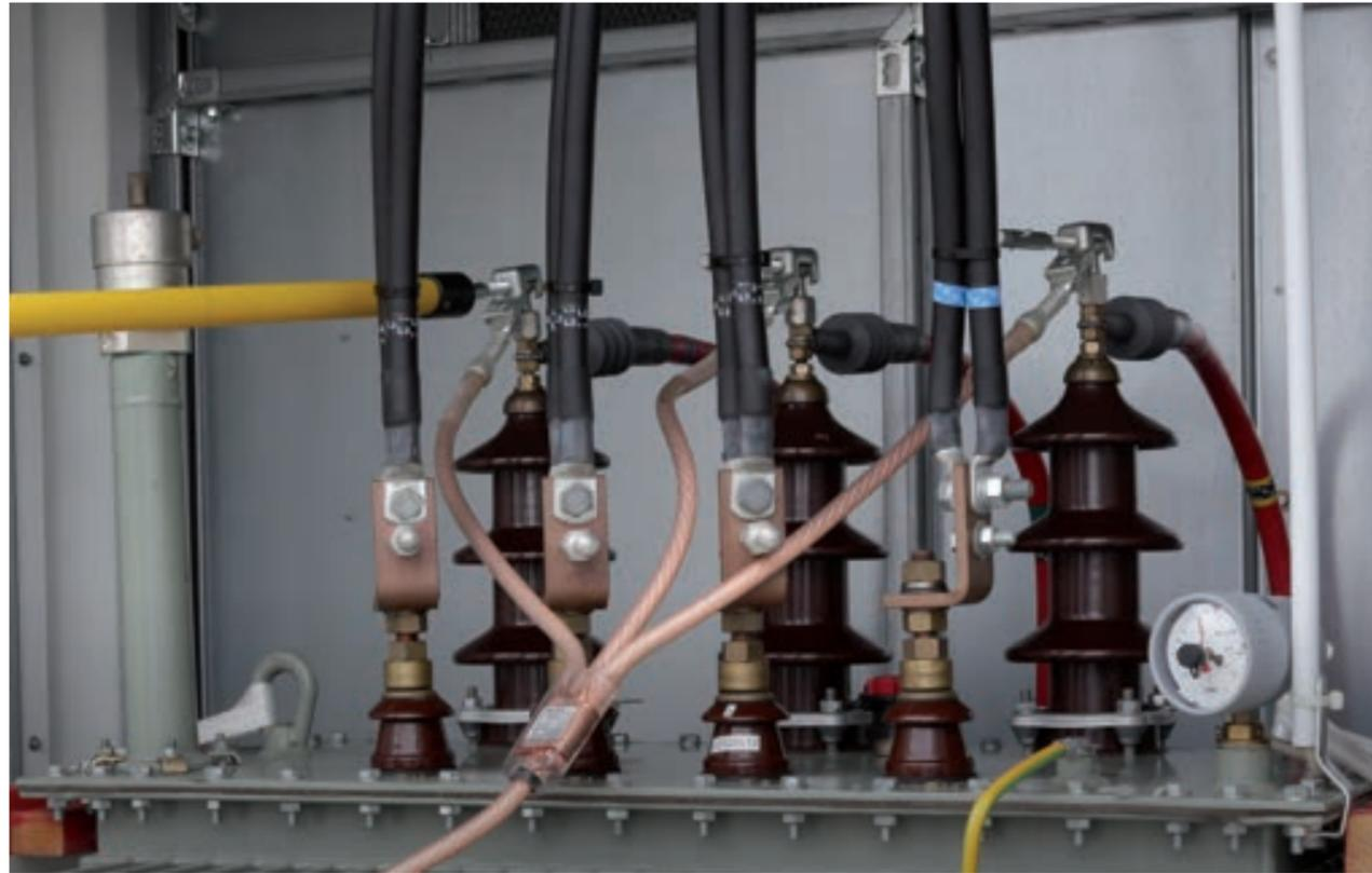
Erdungs- und KurzschlieÙvorrichtungen mit reduziertem Erdseilquerschnitt können in allen Netzen ohne direkte Sternpunkt-erdung eingesetzt werden (siehe IEC 61230 bzw. VDE 0683-100). Bei Netzen mit direkter Sternpunktterdung müssen KurzschlieÙ- und Erdungsseilquerschnitt gleich sein.
