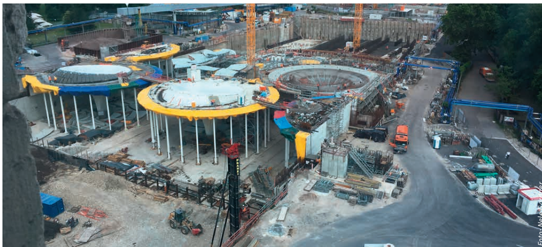
Baustelle in Stuttgart
