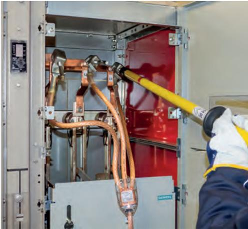
Erdungs- und KurzschlieÙvorrichtungen sind ortsveränderliche Geräte zum vorübergehenden Erden oder Erden und Kurzschließen freigeschalteter oder spannungsfreier Anlagen.
