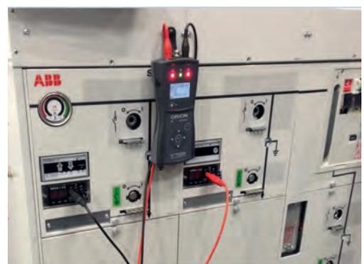
Der Orion 3.1/M.1 ist ein kombiniertes Anzeigergerät für Spannungsprüfung, Phasenvergleich und Schnittstellenprüfung an HR- und LRM-Schnittstellen.
